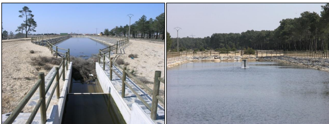
Figuras 7. a). Balsa de infiltración en el municipio de Gomezserracín, y b). Balsa de infiltración en el municipio de Narros de Cuéllar.
