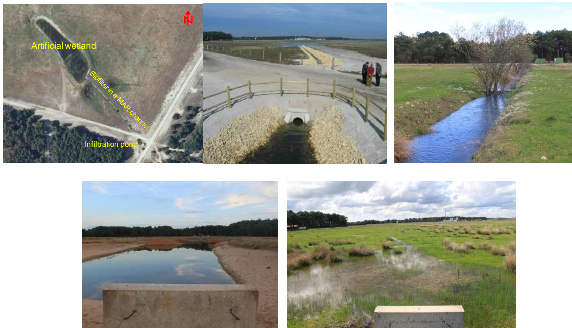
Figuras 9. a). Esquema del sistema “tripleta” del Carracillo, b). Balsa de infiltración, c). Canal biofiltro, d). Humedal artificial y e). Campo de inundación.
