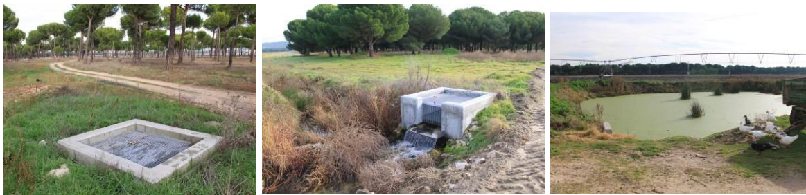
Figuras 14. Puntos singulares del sistema del área de Alcazarén. a). EDAR de Pedrajas; b). Punto de conexión donde convergen las aguas procedentes de la EDAR, el Río Pirón y el canal de escorrentía; c). Canal de escorrentía de la localidad de Pedrajas; d). Aliviadero; e). Válvula 2 caja de monitoreo y f). Arenero reutilizado como balsa de infiltración (fig. 13, A.W. 2).
