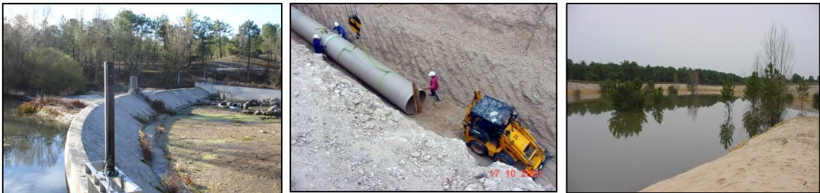
Figuras 6. a). Presa Salto de Abajo en el Río Cega. b). Tubería de conducción hasta el municipio de Gomezserracín y c). Antiguo arenero reformado como balsa de infiltración en Gomezserracín.
